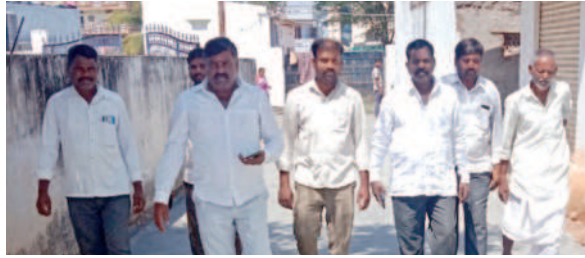
సిమెంట్ రోడ్డు నిర్మాణ పనులను పరిశీలిస్తున్న సర్పంచ్ జిల్లెల వెంకట్ రెడ్డి,తదితరులు
